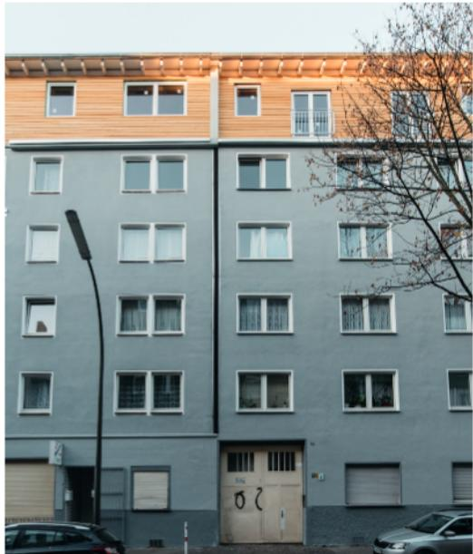
Beispiele aus Dortmund: Holz als untergeordnetes Material, hier bei einer Aufstockung eingesetzt und als Rahmen-Material verwendet.
