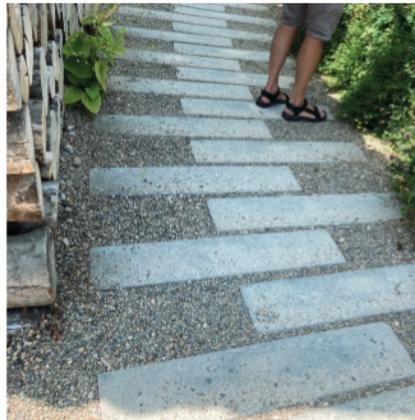
Beispiele aus den Niederlanden: Entsiegelte Wegflächen ermöglichen Versickerung, links mit Regenabfluss
