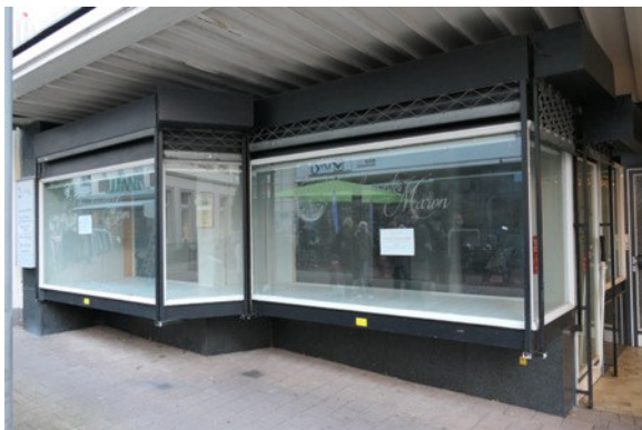
Abb. 18 leerstehendes Ladenlokal auf der Nordstraße (Bildquelle: scheuven + wachen plus)
