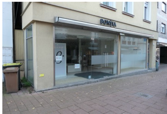
Abb. 19 leerstehendes Ladenlokal auf der Nordstraße (Bildquelle: scheuven + wachen plus)
