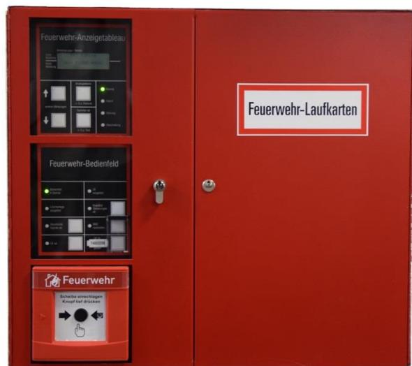
Die BMA wird als zweiflügeliger Stahlschrank ausgeführt. Die linke Tür wird mit einem Halbzylinder der Feuerwehrsicherung ausgestattet, die rechte Tür, wo hinter sich die Feuerwehr-Laufkarten befinden, ist mit einer Schließung des Betreibers versehen.
